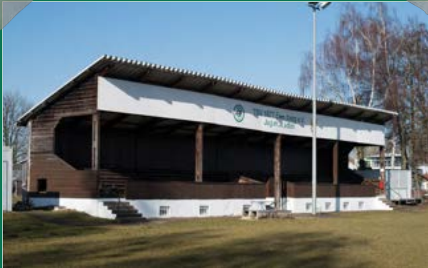
Die alte Tribüne kurz vor dem Abriss 2017
